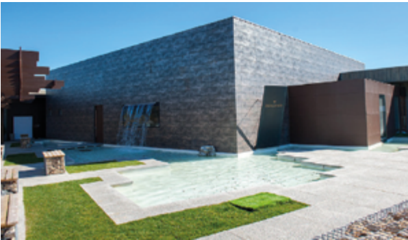
Complejo hostelero Árbore da Veira
